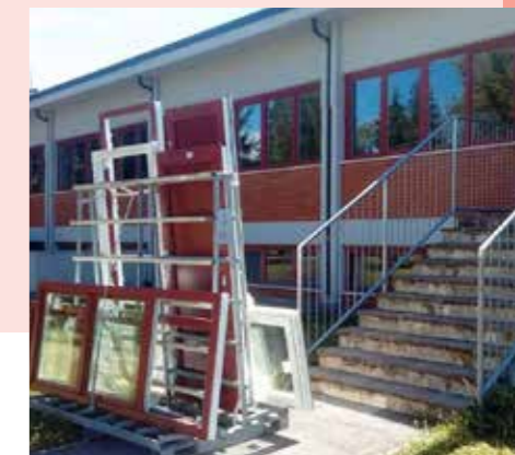
Nuovi serramenti alla Scuola Media
