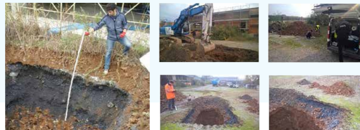
Sopralluogo di ARPA presso il Polo scolastico
